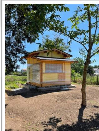
外観がほぼ完成している茶室
